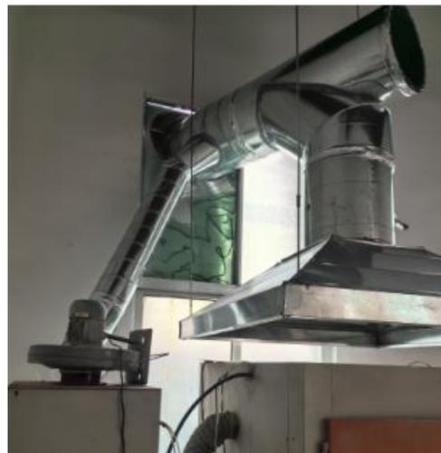
喷砂废气收集净化装置（水喷淋吸附）
