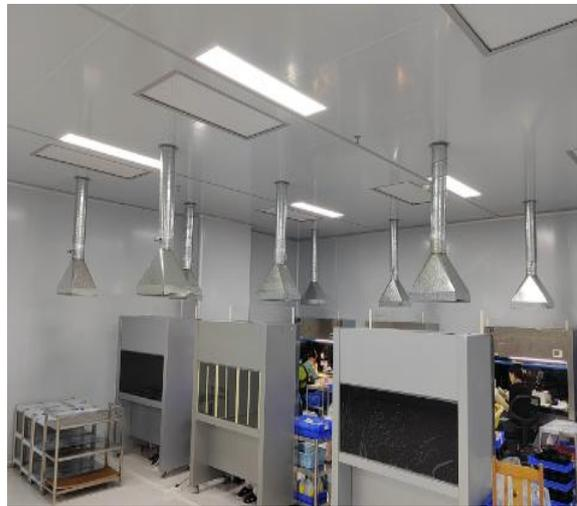
车间酒精擦拭废气收集及净化装置（二级活性炭吸附装置）
