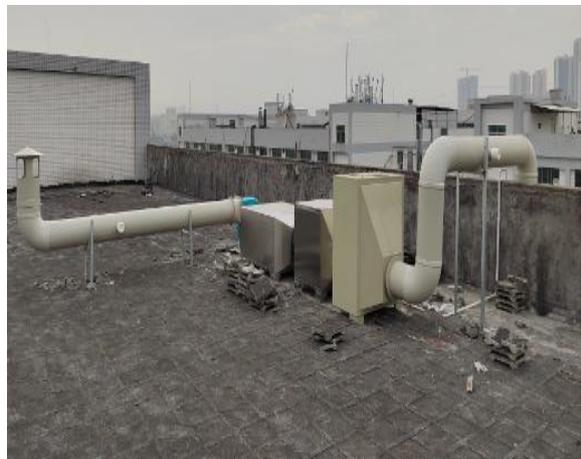
废水处理配套臭气处理设施（密闭收集、UV 光解+活性炭吸附装置）
